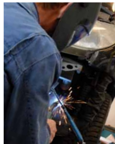
MIG lodning benyttes for at bevare styrken bedst muligt i stålene og sikre den rustbeskyttende zinkoverflade mod unødigt overlast
