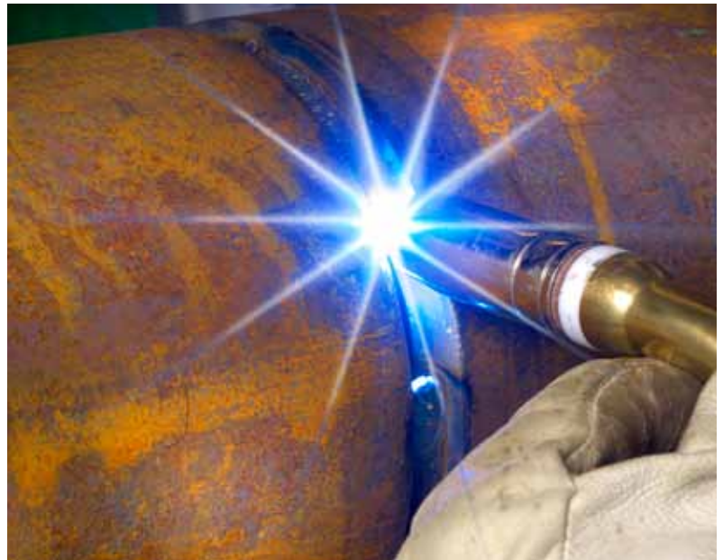
IAC - Faldende svejsning af rodsøm i fjernvarmerør. Hastigheden er væsentlig forøget i forhold til traditionel stigende svejsning.
